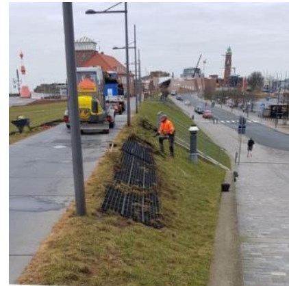
Rasengittereinbau am Weserdeich
