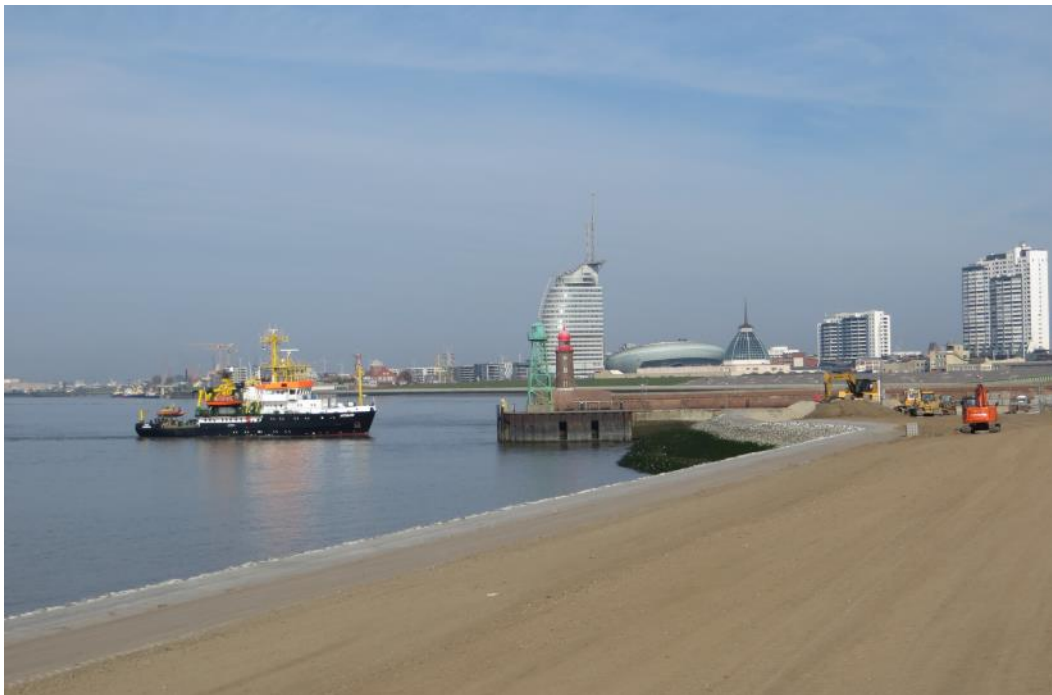
Bauarbeiten zur Verbesserung des Hochwasserschutzes am nördlichen Seedeich
