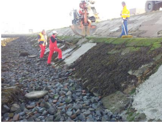
Ausbessern des Deckwerks am Seedeich
