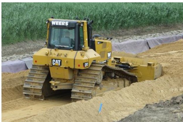
Bauarbeiten am Treibselräumweg auf der Luneplate
