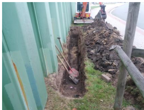
Suchschachtung im Bereich der Dränleitung am Lohmandeich
