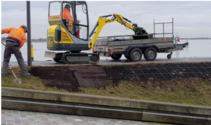
Rasengittereinbau am Weserdeich
