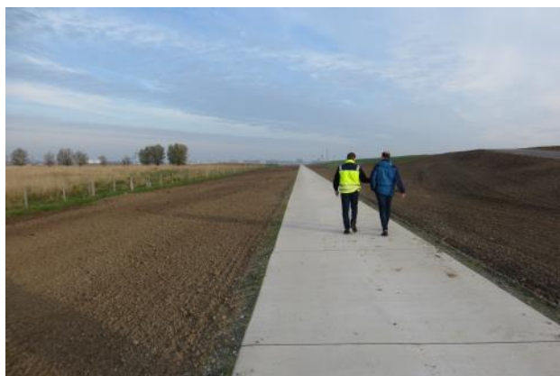
Fertiggestellter Treibselräumweg Luneplate
