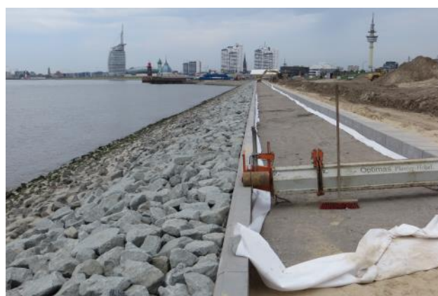
Bauarbeiten am nördlichen Seedeich
