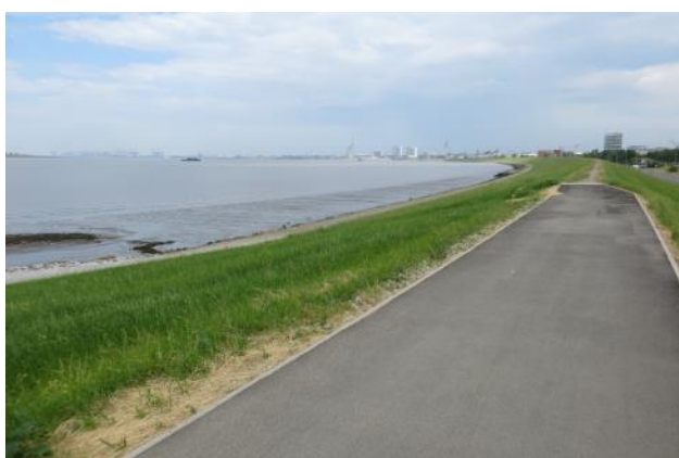
Fertiggestellter Bauabschnitt am südlichen Seedeich
