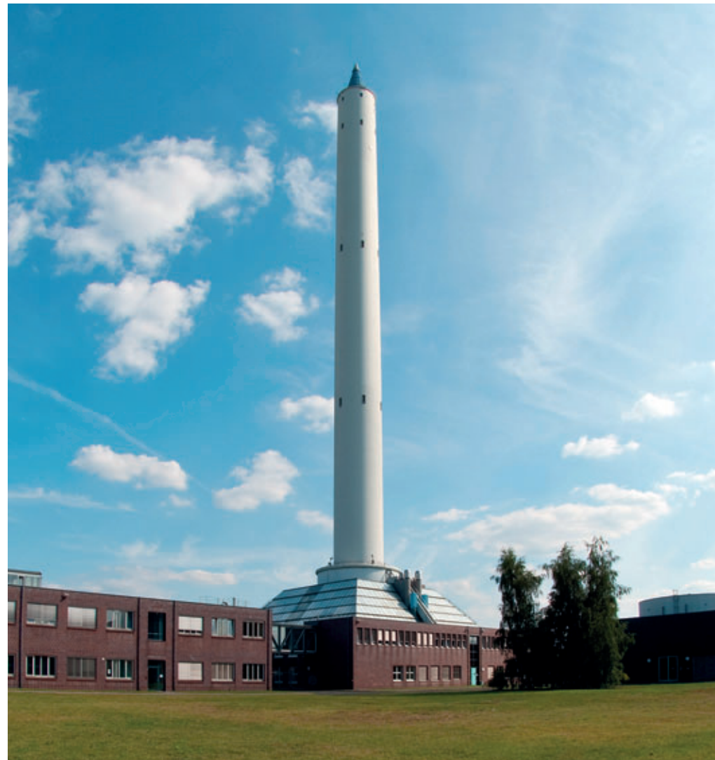
Fallturm im Technologiepark Universität Bremen
