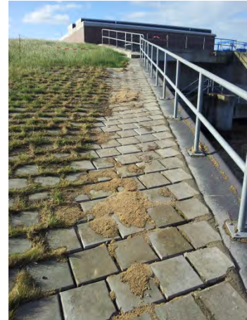
Ausbesserungsarbeiten am Sielbauwerk Norddeich
