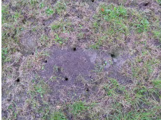
Zugänge zu Wühlmausbauten am Seedeich
