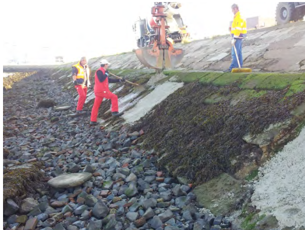
Ausbesserungsarbeiten am Seedeich
