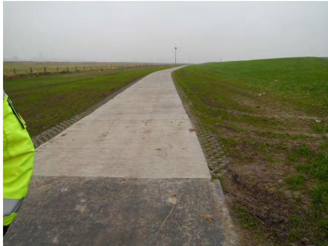
Neuer Treibselräumweg Luneplate
