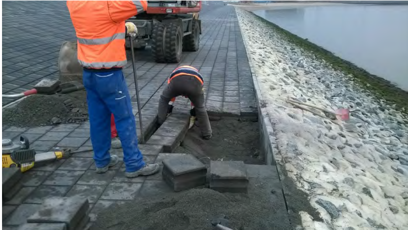
Ausbesserungsarbeiten am Weserdeich
