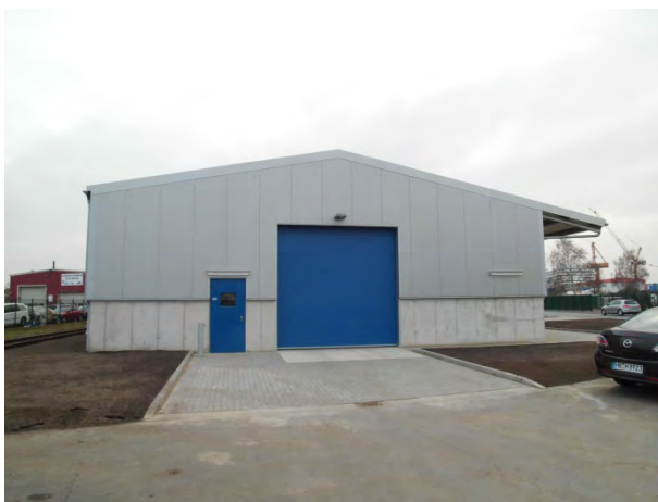
Hochwasserschutzhalle an der Brückenstraße
