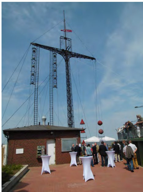
Wiederinbetriebnahme des Wasserstandsanzeigers am 27.06.2014
