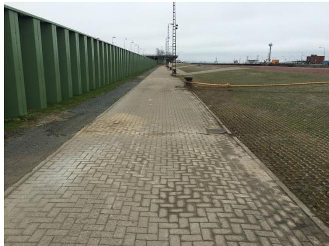
Neue Spundwand neben der Schleusenkammer der Nordschleuse
