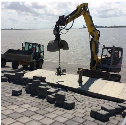
Ausbesserungsarbeiten an den Wellenbremssteinen des Weserdeiches
