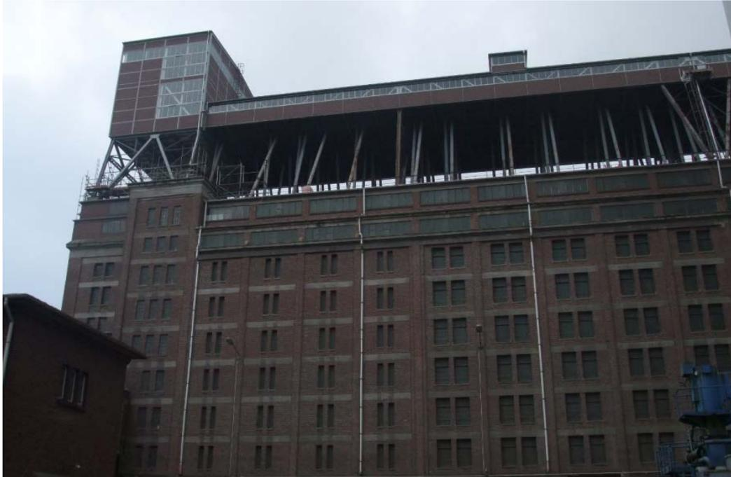
Abb. 22 Kopfstation der Getreideverkehrsanlage mit Bandkanal auf Silo 1 (Quelle: WFB)
