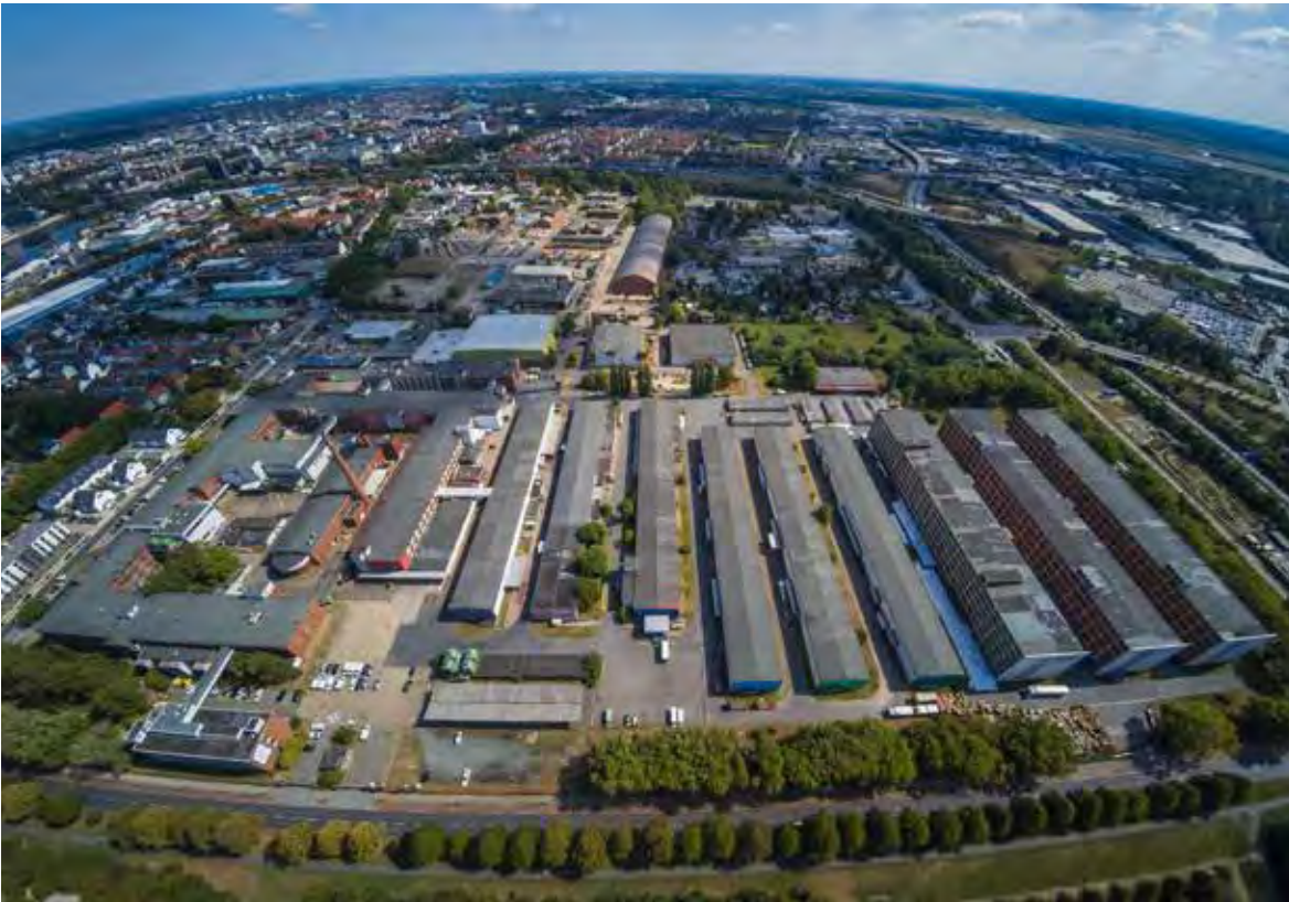
Abb. 17: Blick von Westen auf das ehem. Brinkmannareal
