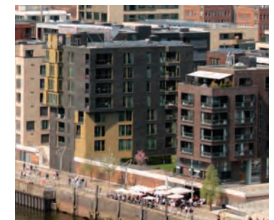
Abb.2: Carsten Lorenzen, KBNK Architekten LRW Architekten, Kaiserkai, Hamburg, DE
