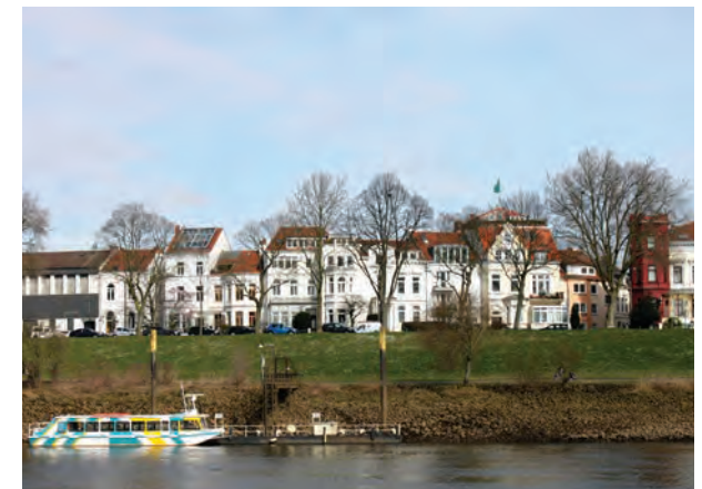
Präzise Baukörper zur Uferkante
