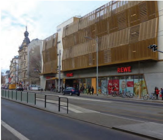
Abb.3: Quartiersgarage Bautzner Straße, Dresden
