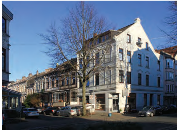
Überhöhte Ecke, Gewerbe im Erdgeschoss
