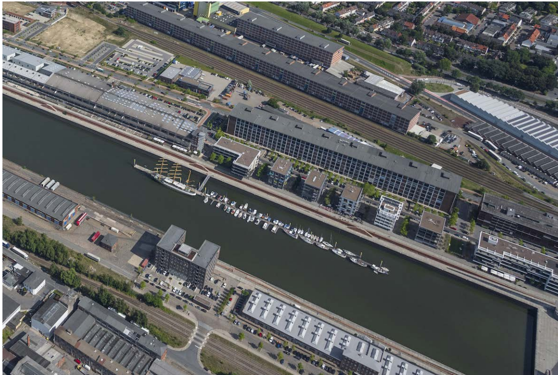
Abb. 36 Nordseite Europahafen östlicher Bereich (Quelle: WFB, terra-air-services)
