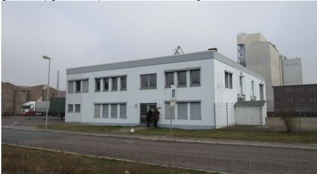
Abb. 26 Büro- und Werkstattgebäude Am Holzhafen 21 (Quelle: WFB)#
