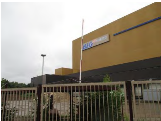
Foto 20 und Foto 21: Standort „Hochregallager“
