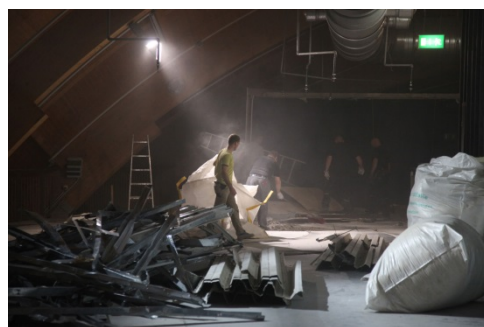
Abb. 4 Rückbau der Ausstellung
