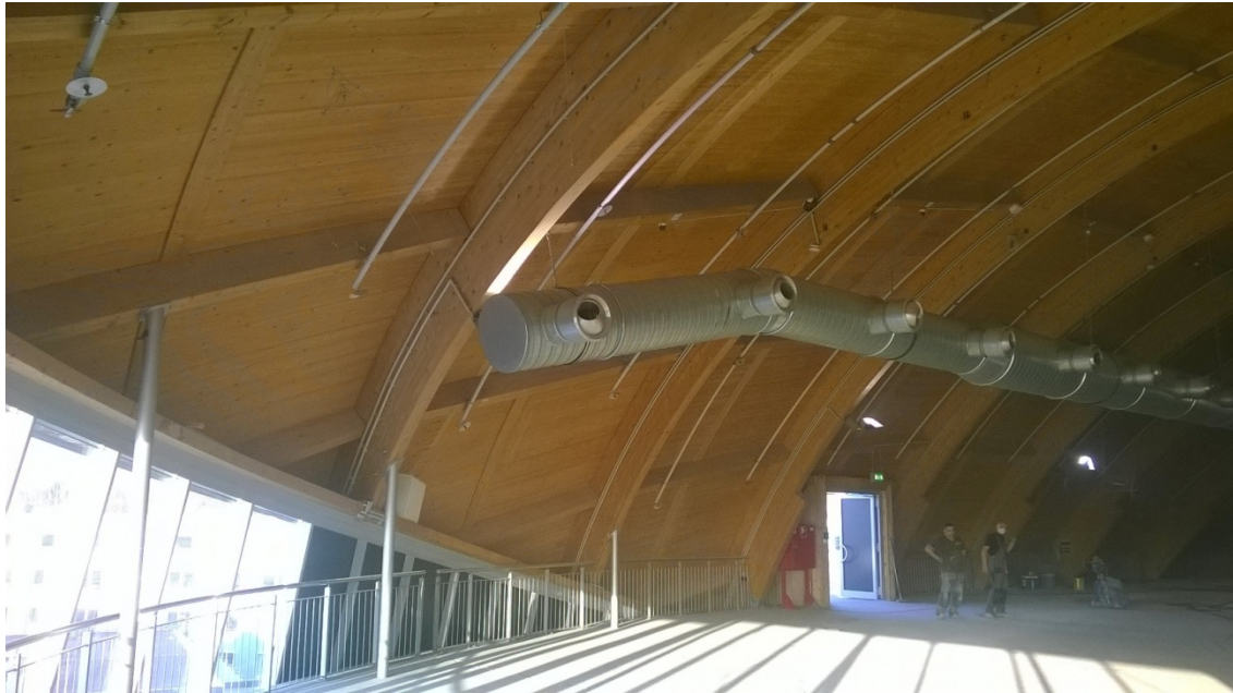
Abb. 7 Anpassung der Lüftungs- und Sprinkleranlagen
